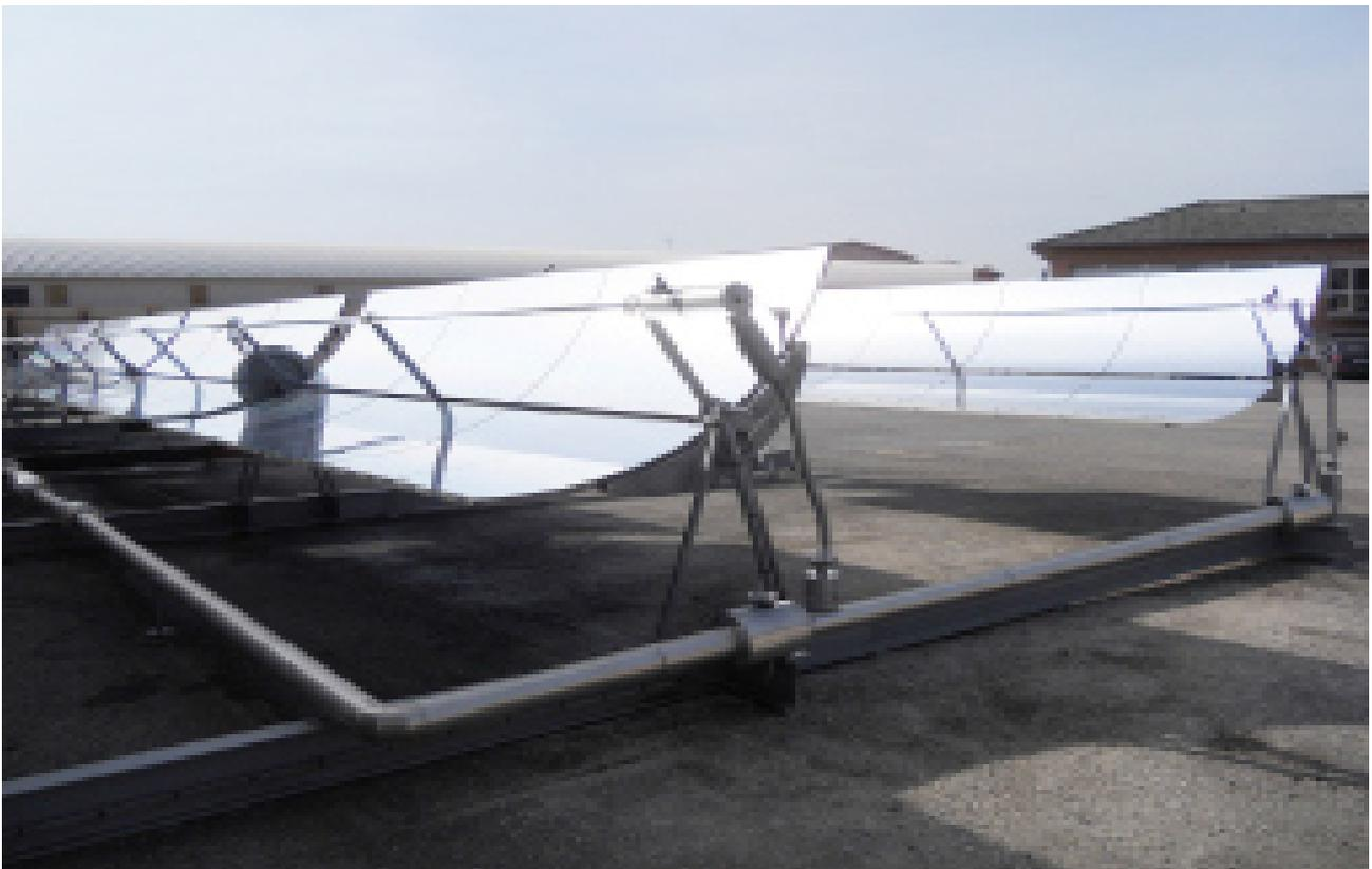
**realizzazione di un'installazione da 2 ton/ora di vapore solare a 10 bar!**
